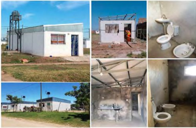
Figura 3: relevamiento en instancia de ejecución y entrega de las unidades. Fuente: elaboración propia (2018)
