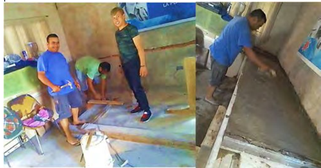
Fig. 9. Ejecución de banquina y mesada de hormigón armado. Fuente: propia
