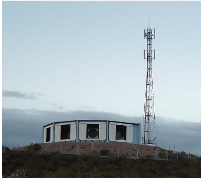
Figura 4.10: Edificio de “Los Leones”. Se observa la torre de comunicaciones y las cortinas metálicas abiertas exponiendo el anillo y el filtro.
