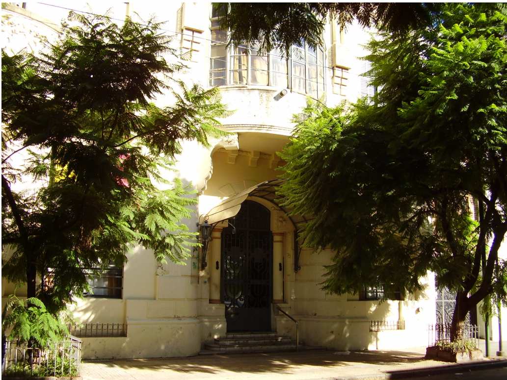
Geriátrico San Nicolás (ubicado en calle 43 N° 518)
