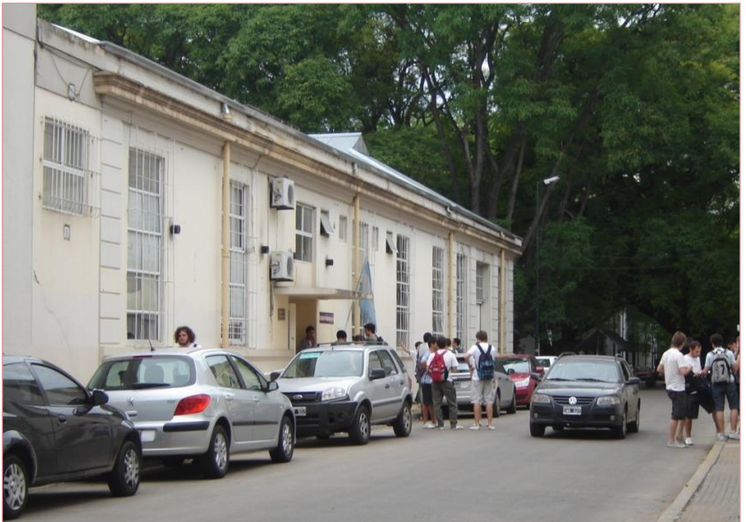
ESTADO PREVIO A LA INTERVENCIÓN – FRENTE SOBRE CALLE 115
