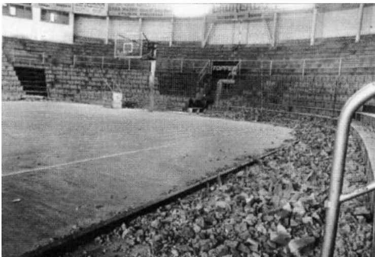
El "Osvaldo Casanova" en plena construcción
