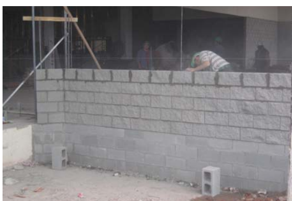
Figura 2 – Mampuesto de hormigón – Medio 1
