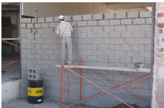
Figura 3 – Mampuesto de hormigón – Medio 2
