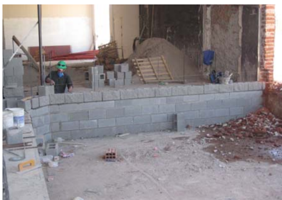
Figura 1 – Mampuesto de hormigón - Arranque
