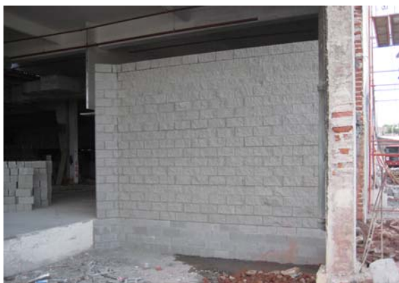
Figura 4 – Mampuesto de hormigón - Final
