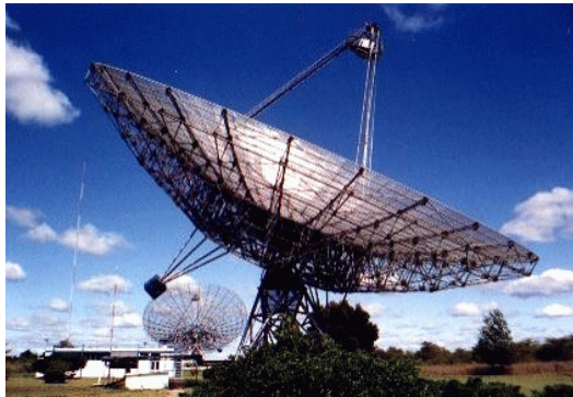
Figura 2.6: Antenas de 30m del IAR.
