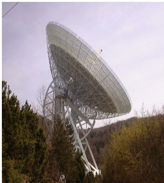
Figura 2.7: Antena de 100m de Effelsberg
