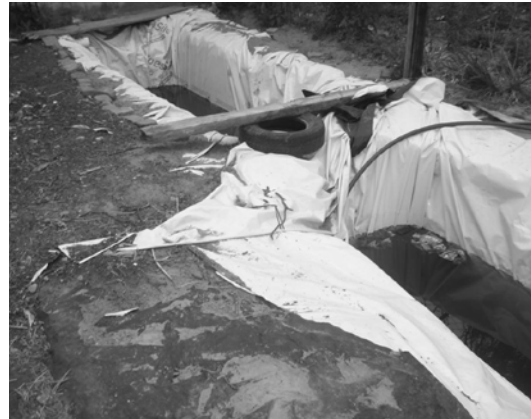
Fig. 4. Mini represa del agua de lluvia que escurre por el suelo
