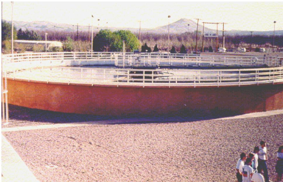
Figura 1.6. Clarificador secundario de una planta de tratamiento de aguas residuales por barros activados
