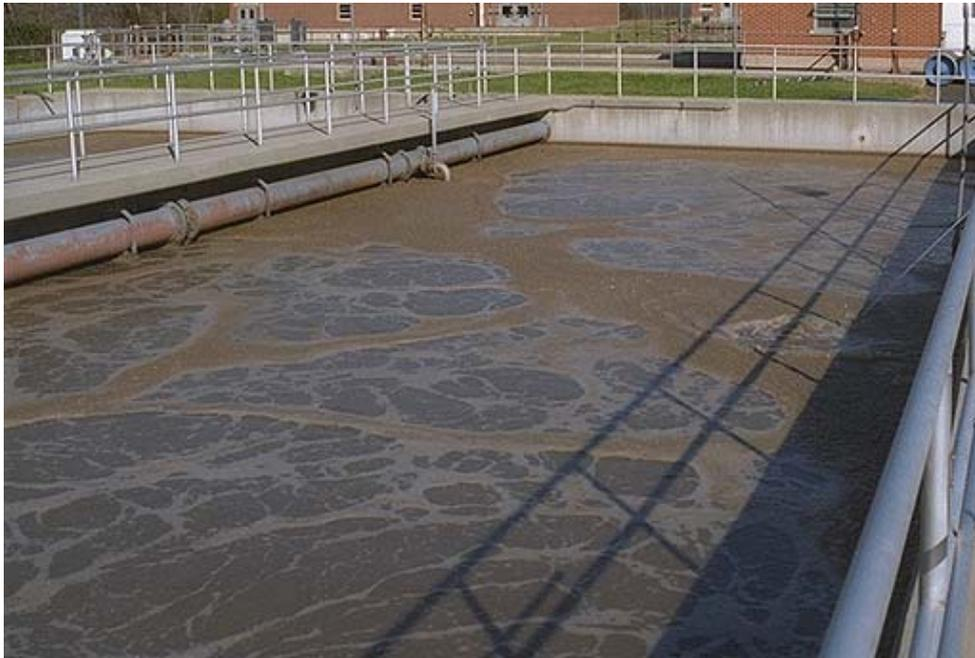
Figura 1.5. Tanque de aireación de una planta de tratamiento de aguas residuales por barros activados
