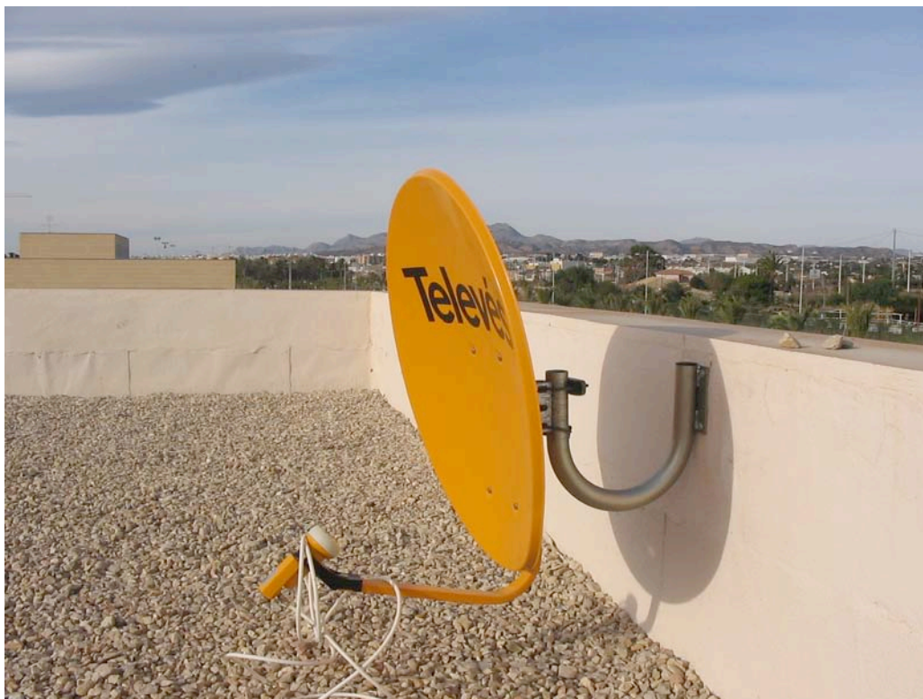
Figura 7: Imagen de la Antena Parabólica Off-Set Ref. 7536 de Televés que se encuentra instalada actualmente en la azotea del edificio departamental en el que se pretende instalar el rotor de antenas.
