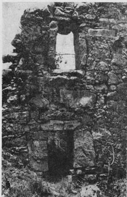
FIG. 4: Vista de una de las edificaciones del centro Chauchaj, situado en la orilla suroccidental del lago Lauricocha.
