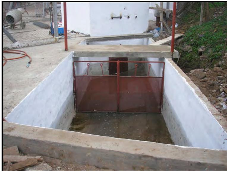
Foto 3.19: Reja de protección acceso a cámara. Estación de bombeo, año 2007
