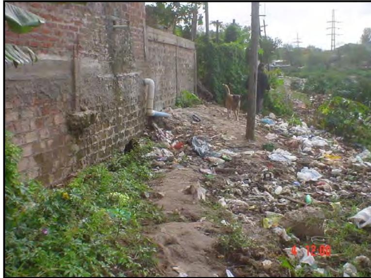
Foto 3.10: Parte posterior de una casa construida sobre el talud. El caño de PVC cloacal (blanco DN110) descarga en un pozo negro ubicado en la parte más baja
