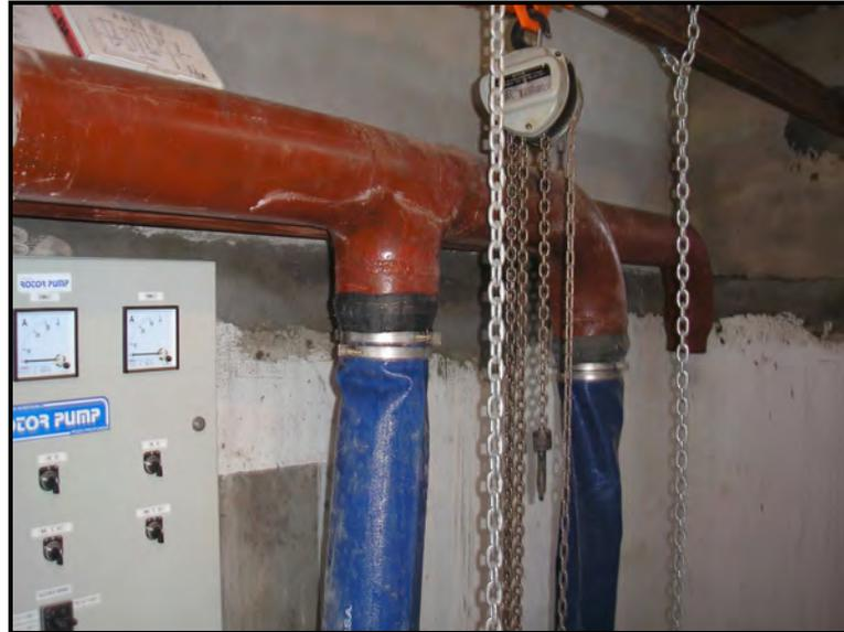
Foto 3.20: Tablero eléctrico, sistema de izaje de electrobombas, Estación de bombeo, año 2007
