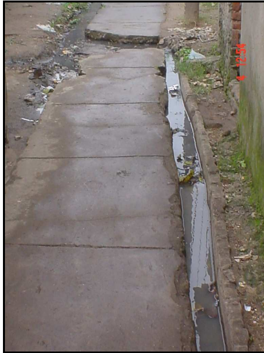
Foto 3.9: Vista de la cuneta/zanja que colecta los desagües domiciliarios
