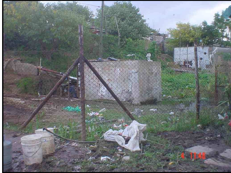
Foto 3.14: Estación de bombeo, año 2001
