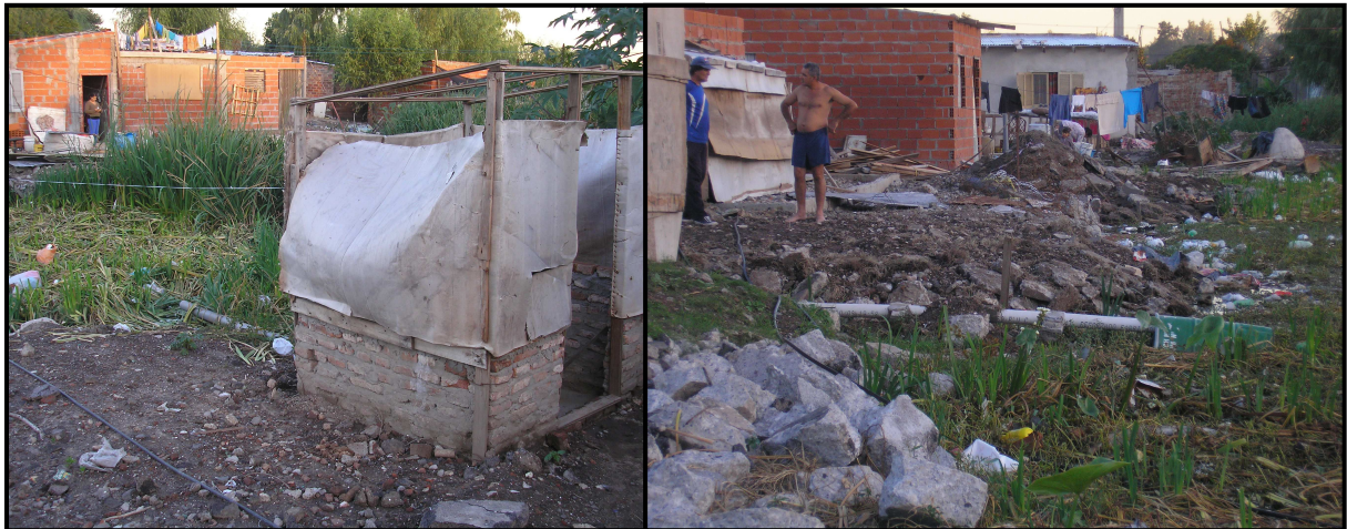
Foto 3.11: Vista de una descarga cloacal directa a la laguna
