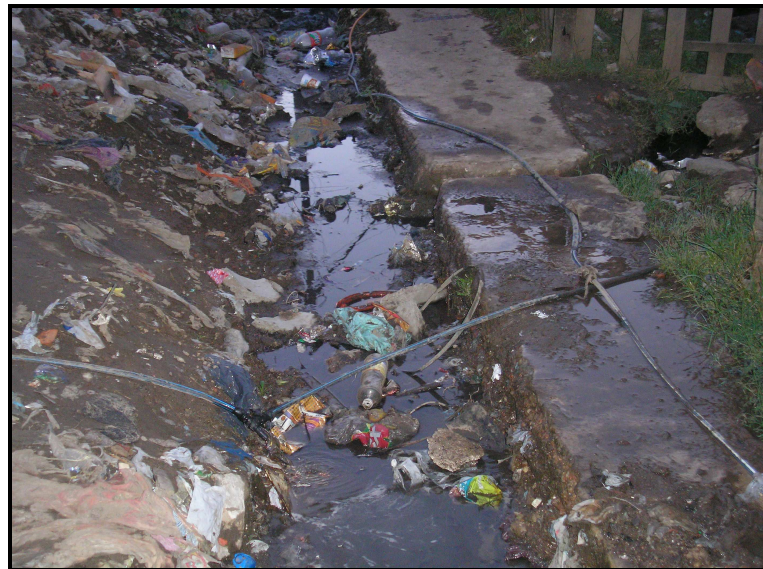
Foto 3.7: Vista de las conexiones a la red de agua potable
