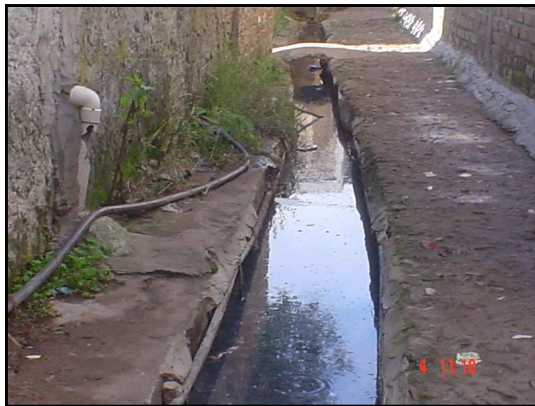
Foto 3.8: Vista del desagüe domiciliario (codo de caño PVC blanco) hacia fuera de la vivienda. Cuneta colectora entre viviendas
