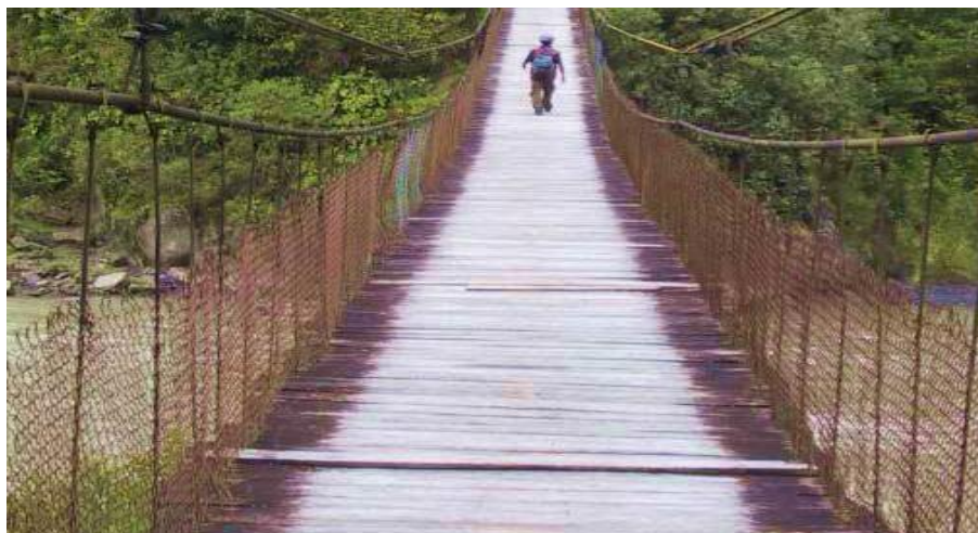
Figura 1. Estágio da Ponte
