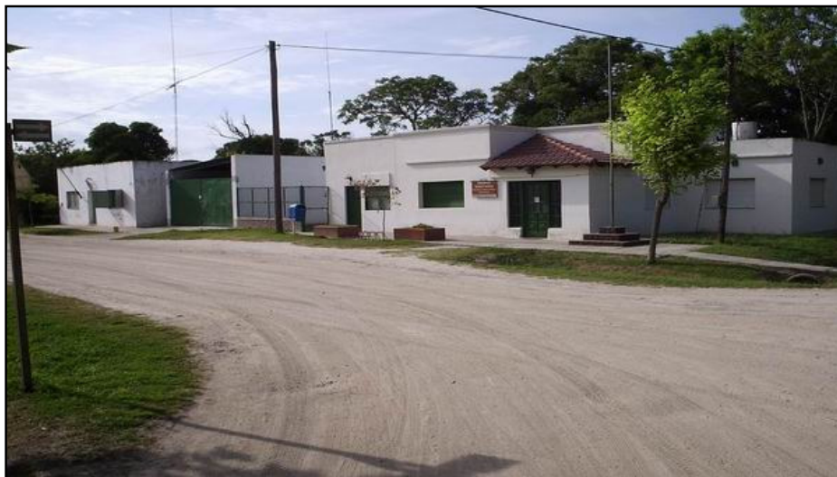
Figura 2.3: Vista del Centro de Salud de Atalaya.
