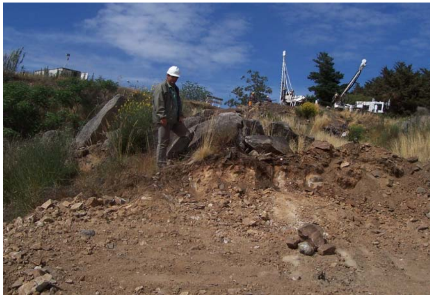
Fotografía 4 - Área de margen izquierda – En primer plano se observan las rocas alteradas y fracturadas constituyentes de la zona litoestructural 1 del macizo rocoso, único afloramiento en dicha margen, y en segundo plano los materiales antrópicos no cohesivos a los que se hace alusión en párrafos anteriores.
