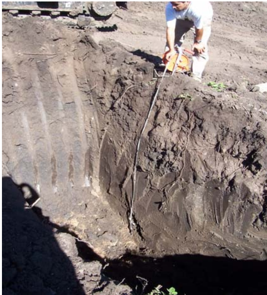
Fotografía 1 - Calicata MDC5 – Eje de la presa - 2,80 metros de sedimentos fluviales limo arcillosos.
