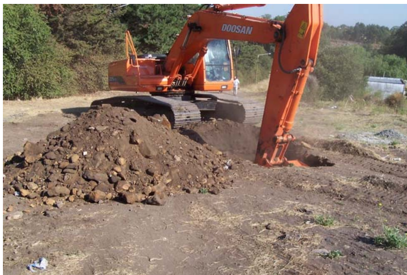
Fotografía 3 - Calicata MIC1 – Área del estribo de margen izquierda - Material antrópico no cohesivo que deberá ser excavado para la realización del empotramiento y por razones de inestabilidad (colapso ante eventual saturación)
