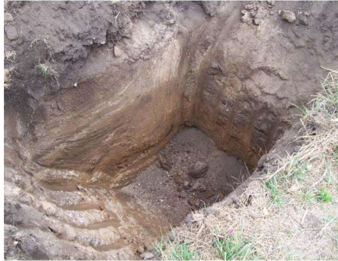
Fotografía 2 - Calicata MIC11 – Presencia de sedimentos limo arenosos del Pampeano. Se lo podría utilizar para la construcción de las ataguías del canal de desvío.
