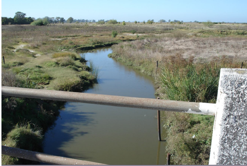
Figura N° 2 Arroyo El Pescado (Ruta N° 11 y arroyo)
