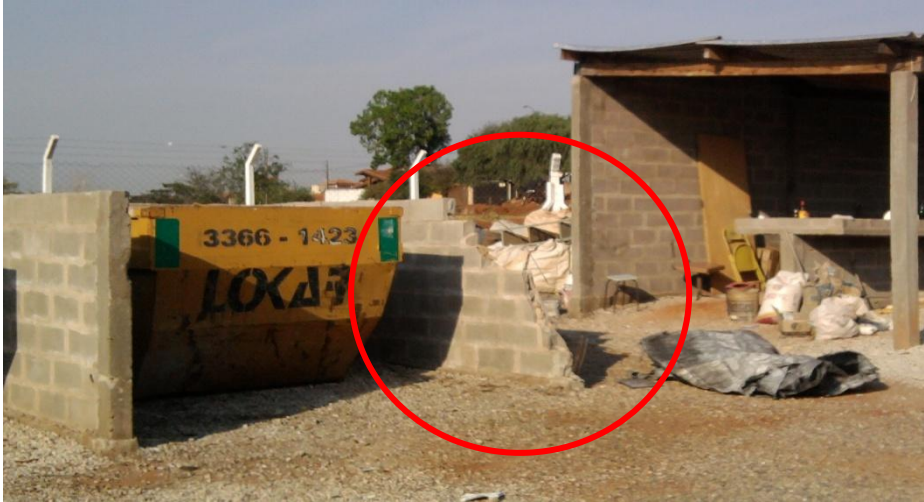
Figura 5. Avaria na estrutura física causada pelo espaço insuficiente para manobras de automóveis, no Ecoponto do Jardim Paulistano.
