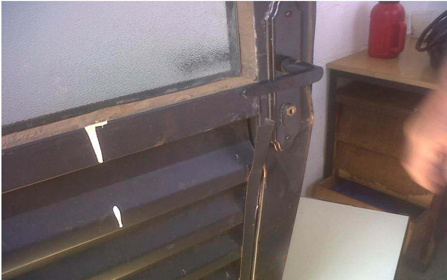
Figura 9: Porta da guarita com sinais de arrombamento no Ecoponto do São Carlos III.
