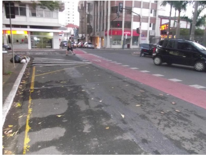
Figura 6. Ciclofaixa entre o ponto de ônibus e o tráfego de veículos na Rua 06.
