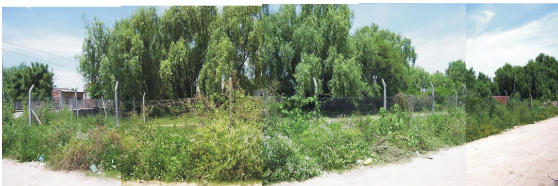
Foto 33: UT 2: Tramo del arroyo cegado y posesionado por un particular en el tramo del arroyo entre calles Libertad e Independencia.
