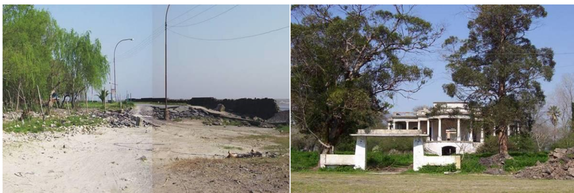
Fotos 14 y 15: Degradación del espacio público: Paseo Costanero en Punta Lara; y Palacio Piria, respectivamente.
