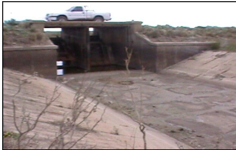
Foto 7.7: Vista de una compuerta lateral del Canal N°5
