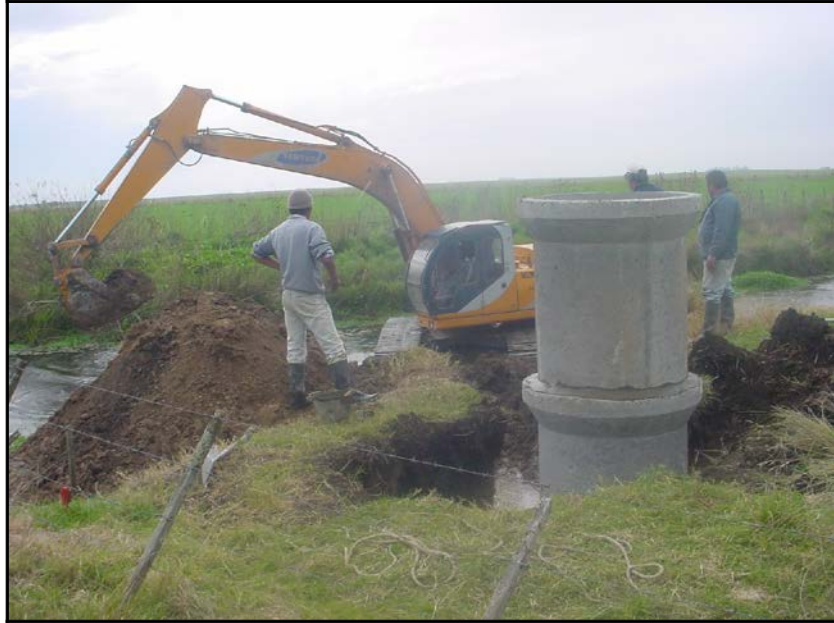
Foto 7.12: Instalación de una estación de registro de niveles.
