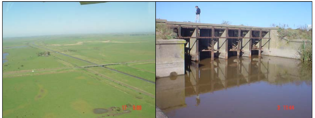
Foto 7.9: Puente de la RP56 sobre el Canal N° 2 y una compuerta lateral cercana.
