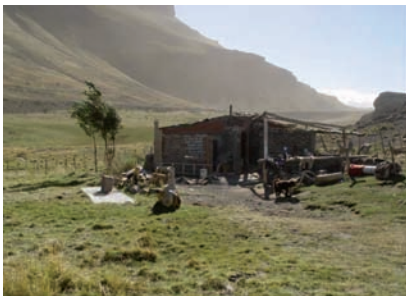
Foto 1: Vivienda de un productor en los campos de veranada
