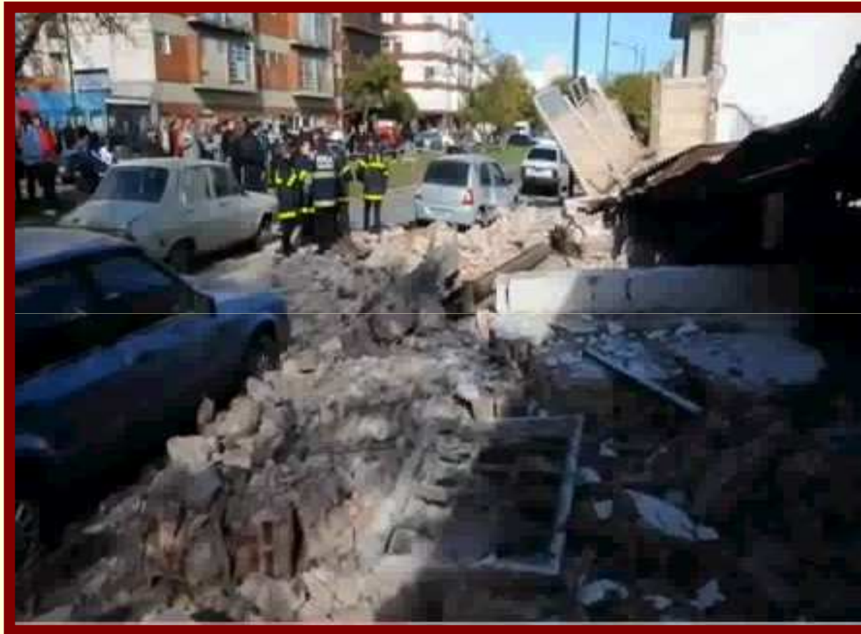
Derrumbe en 4 y 38 – La Plata
