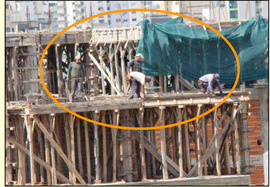
Realización del encofrado (5º piso):
