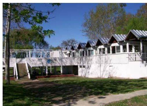
Figura 20: Equipamiento Punta Lara. Dirección de Arquitectura. MOP. Roberto Capelli y otros. 1964
