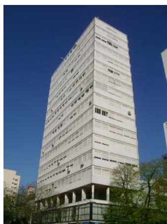
Figura 15: Baum y Kadisevich - edificio 7 y 55. Carozo Gomez
