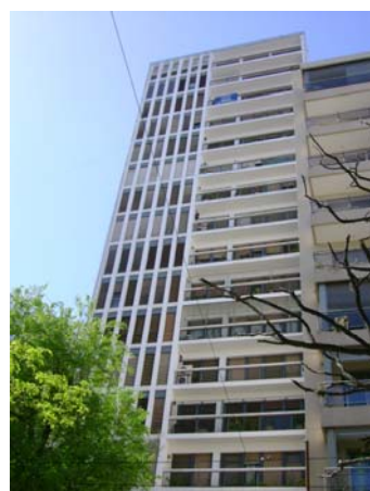
Figura 16: Edificio 45 e/ 6 y 7 Chel Negrin
