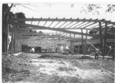
Figura 2: Construcción de los Talleres de Arquitectura en madera laminada- 1962
