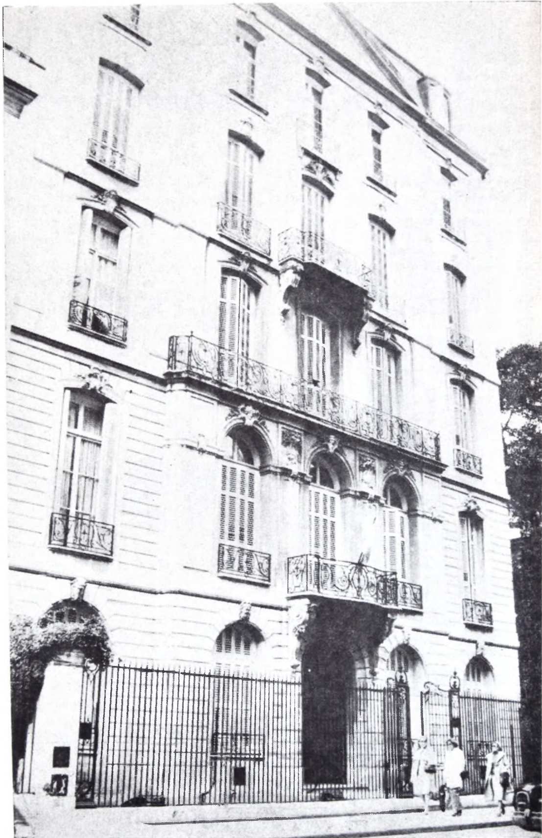
Fachada de la Casa de las Academias, Av. Alvear 1711, Buenos Aires, R. Argentina.
