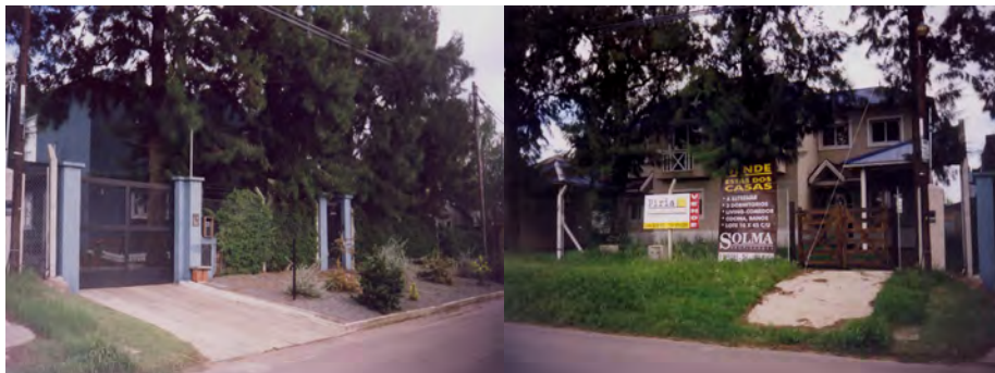
Fotos A7 y A8. Nuevas Viviendas y Viviendas en Venta, que dan cuenta del proceso de valorización inmobiliaria del Sector. Fuente: Foto de la Autora.
