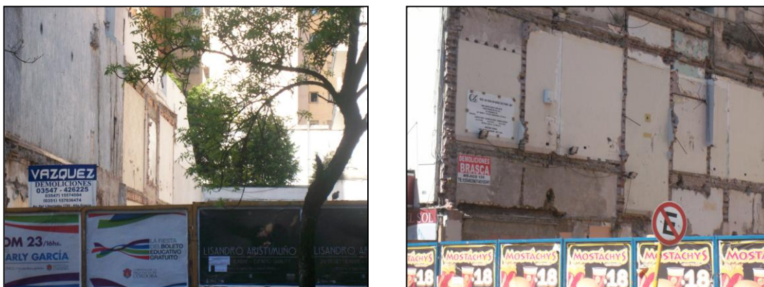
Foto 10 Nuevos objetos urbanos en producción en el área central de la ciudad Demoliciones de construcciones bajas y, nuevas construcciones en altura en proceso Fuente: Buffalo L.
