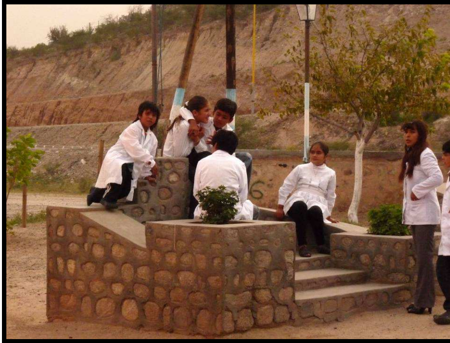
Figura 5. La piedra en la construcción actual (Escuela de La Ciénaga de Abajo)
