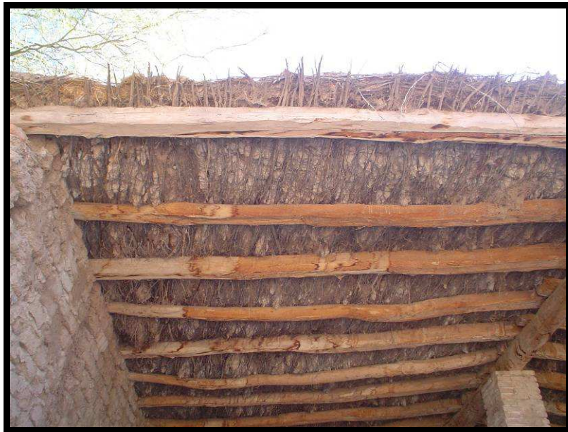
Figura 1. Algunos de los materiales modernos usados en la construcción de las viviendas del valle (paredes de ladrillo cocido, vigas de álamo y enramada de acacia)
