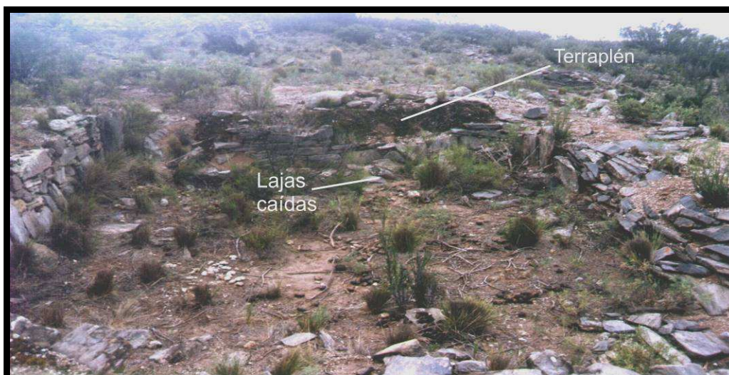
Figura 11. Paredes del recinto 16. Se observa el terraplén descubierto por la caída de rocas metamórficas que conforman la pared este
