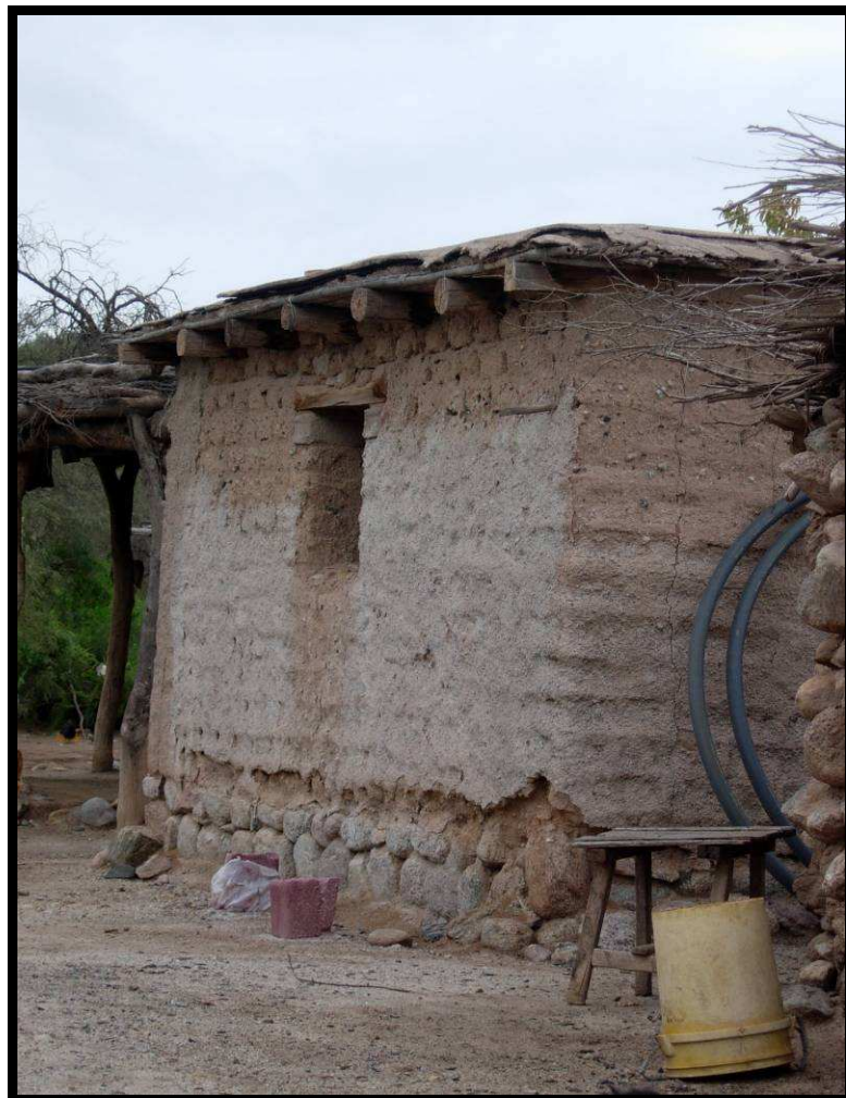
Figura 3. Casa tradicional de La Ciénaga de Abajo, con basamento de piedras y paredes de adobe
