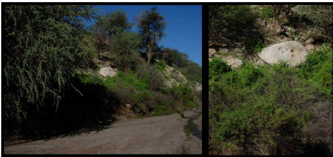
Figura 24. Mortero fijo derrumbado sobre barranca a la vera del río Ichanga.
