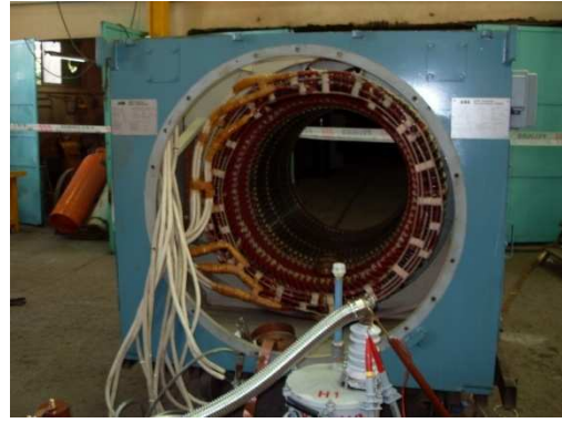
Fig. 6 - Ensayo "surge" a motor sincrónico 5.500 HP, conexión a las bobinas.
