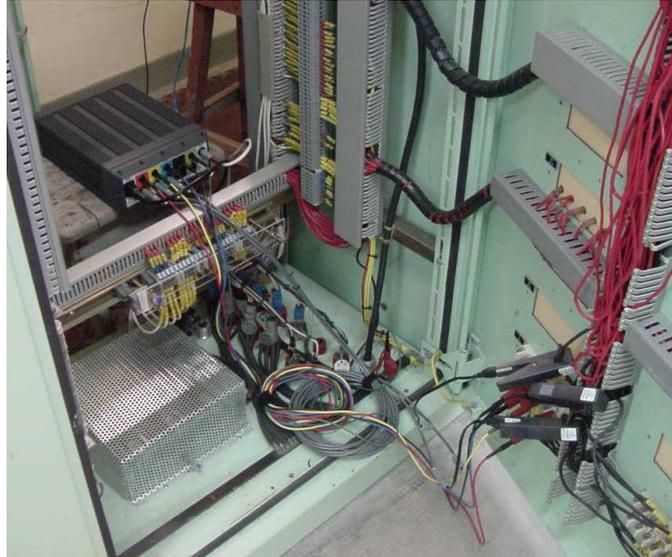
Fig. 3. Equipo de registro conectado en una de las EETT.
