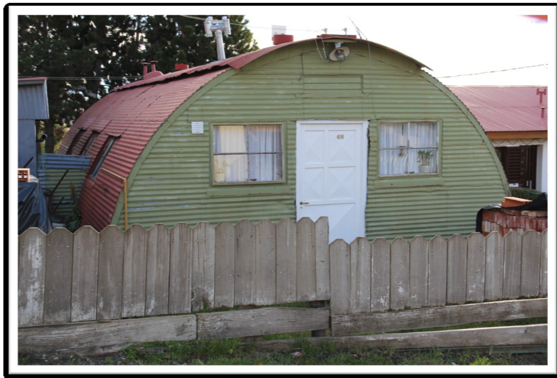
Casas de medio caño. Primeras construcciones habitaciones en Río Turbio emplazadas en el 1945. Fotografía tomada para esta tesis. Abril 2011
