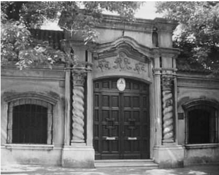
Arquitectura Neocolonial: Casa de Ricardo Rojas por Angel Guido en Buenos Aires. (1927).
