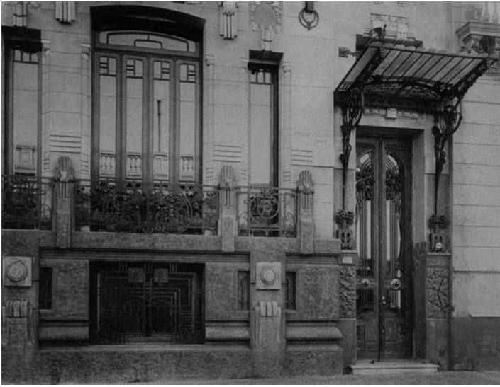
Arquitectura del Arte Nuevo: Casa particular por Virginio Colombo en Buenos Aires. (1909).
