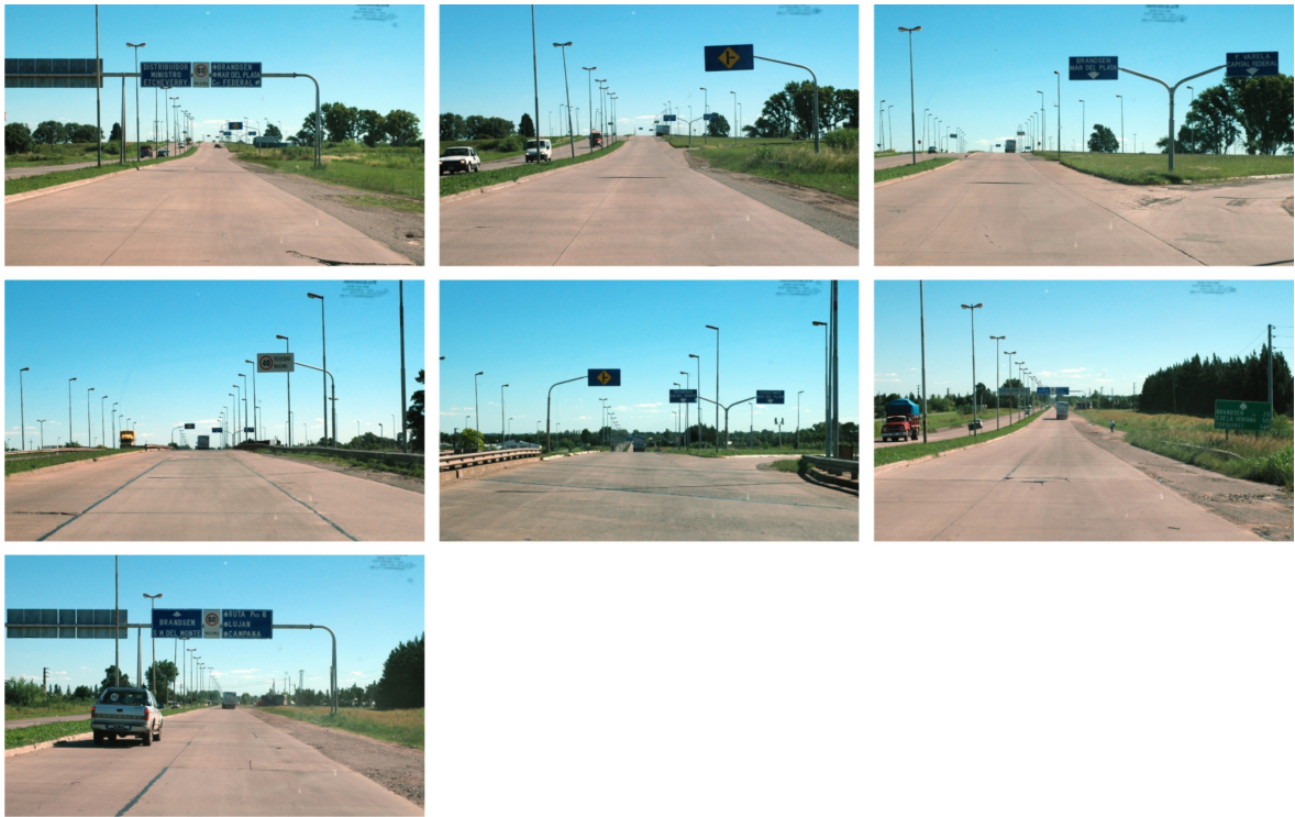
Señalamiento Informativo existente en RP215 en el Distribuidor Etcheverry circulando hacia el Empalme RP 6 / San Vicente / Brandsen
