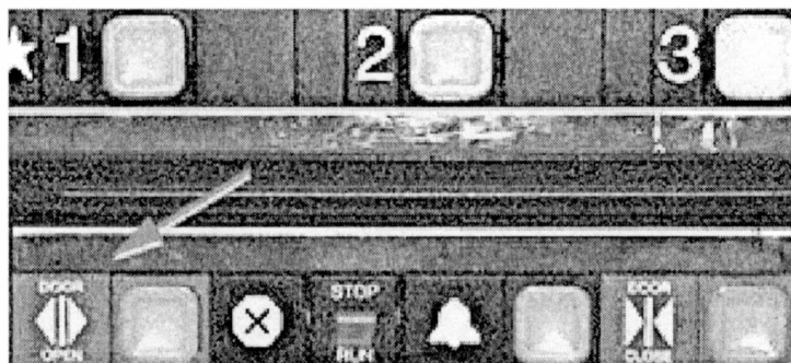
Figura 4.1 – Distribución de la botonera de un ascensor
