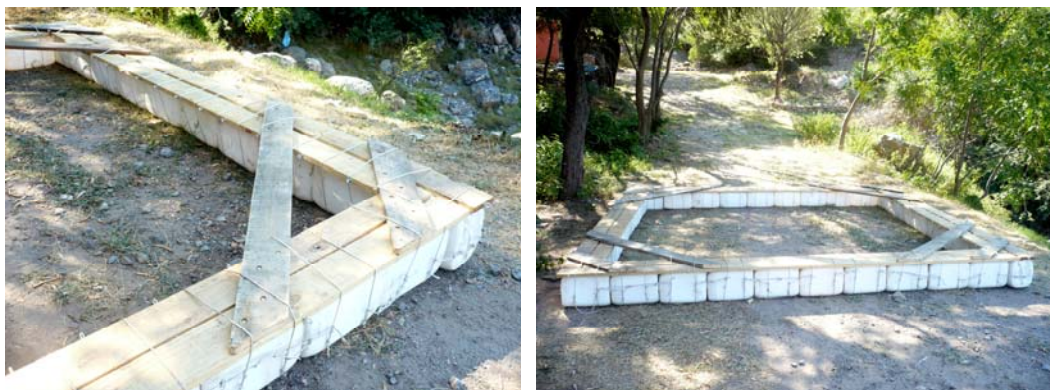
Figura III.4: Marco de las jaulas completo, con su estructura de madera y los bidones de flotación instalados.
