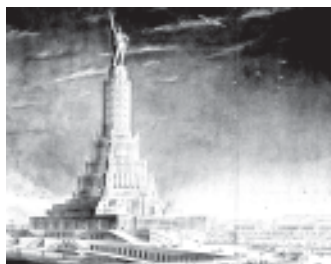
Figura 2. El proyecto ganador aunque nunca concluido, de Boris Iofan, de los años 30, en el concurso para la construcción del Palacio de los Soviets, Moscú.
