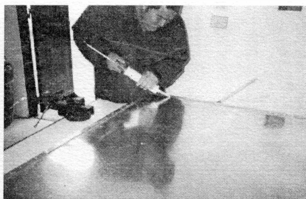
Figura 7. Operarios barriales. Desarrollando el proceso de montaje y sellado de cajas del colector
