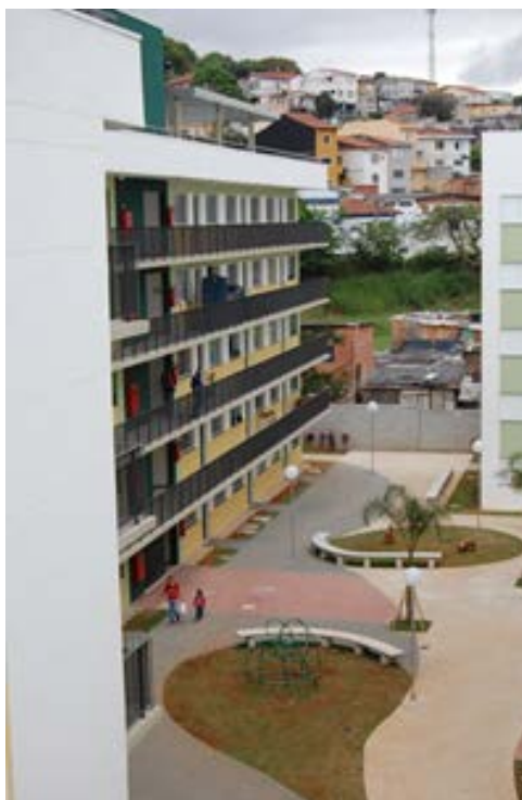
03. Conjunto de viviendas Jaguaré, de bajos recursos en San Pablo. Brasil
