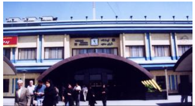
La imagen muestra la salida de la Estación Teherán del transporte subterráneo de la capital iraní. El proyecto ha representado uno de los más significativos emprendimientos urbanos contratados con China.
