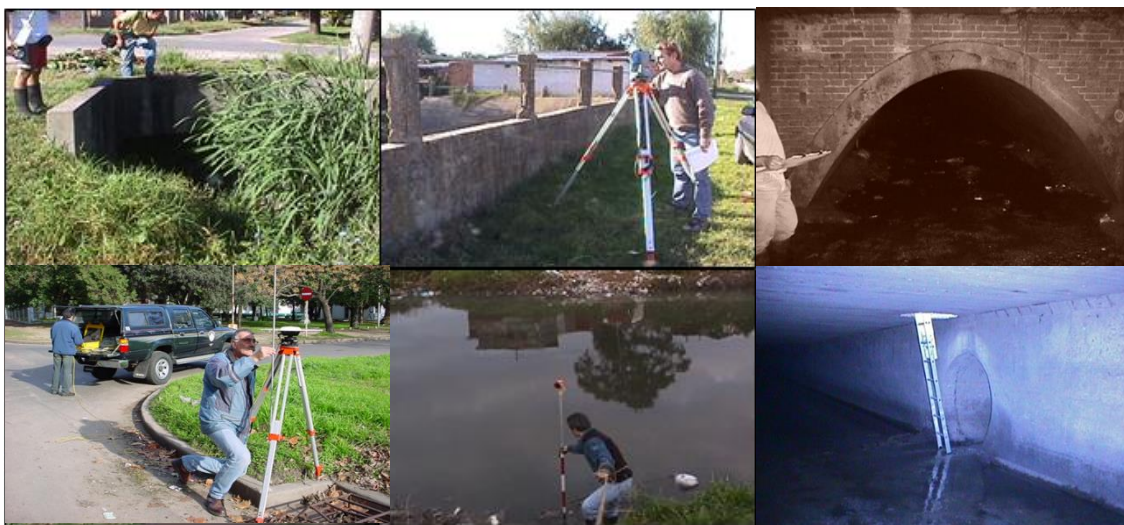
Figura 3 – Tareas de relevamiento en la cuenca del arroyo del Gato
