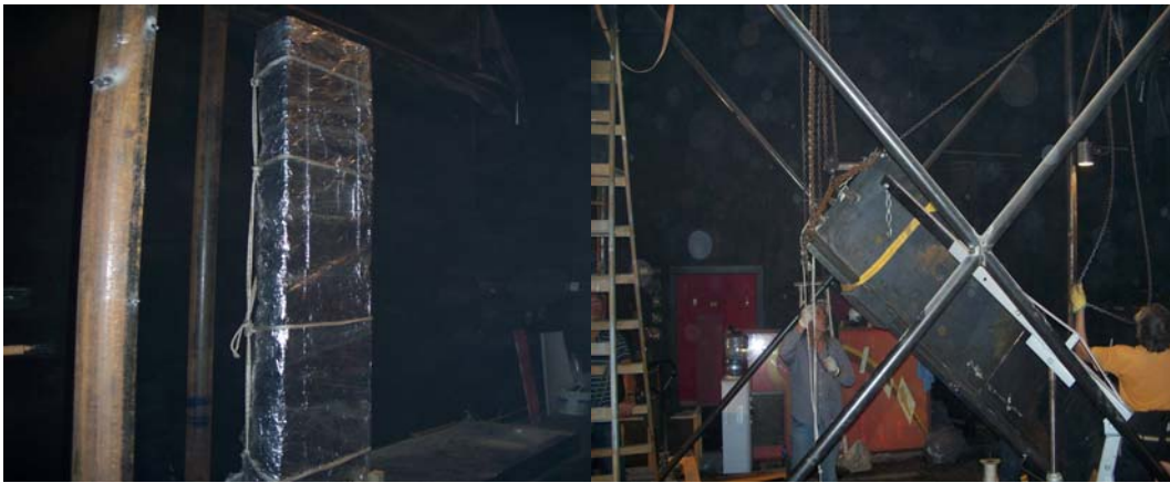
Foto 3 Desmontaje Pieza N° 70048
