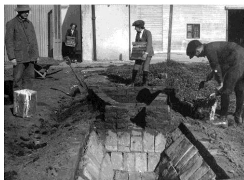
Los alumnos construyen una pileta para apagar la cal viva.
