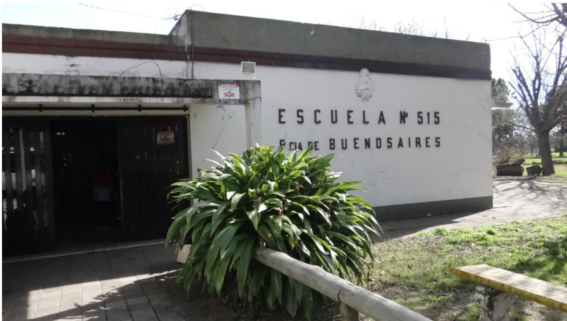
Fachada Escuela N° 515
