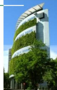
CONSORCIO NACIONAL DE SEGURO Santiago de Chile, Chile. 1993 Arquitecto: Browne-Huidobro
