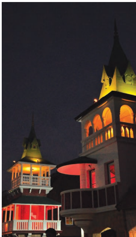
Hoy y ayer en los distintos sectores. Abajo, la avenida central (que abre esta nota) en plena construcción. Fueron 1.600 los obreros que aprendieron y enseñaron oficios.
