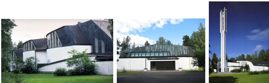
Figura 7. Fachada N-NO; Acceso principal, conjunto principal
