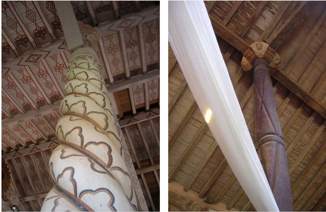
Figura 11. Detalle columnas. Chiquitos, Santa Cruz de la Sierra. Bolivia. Mayo 2010.
