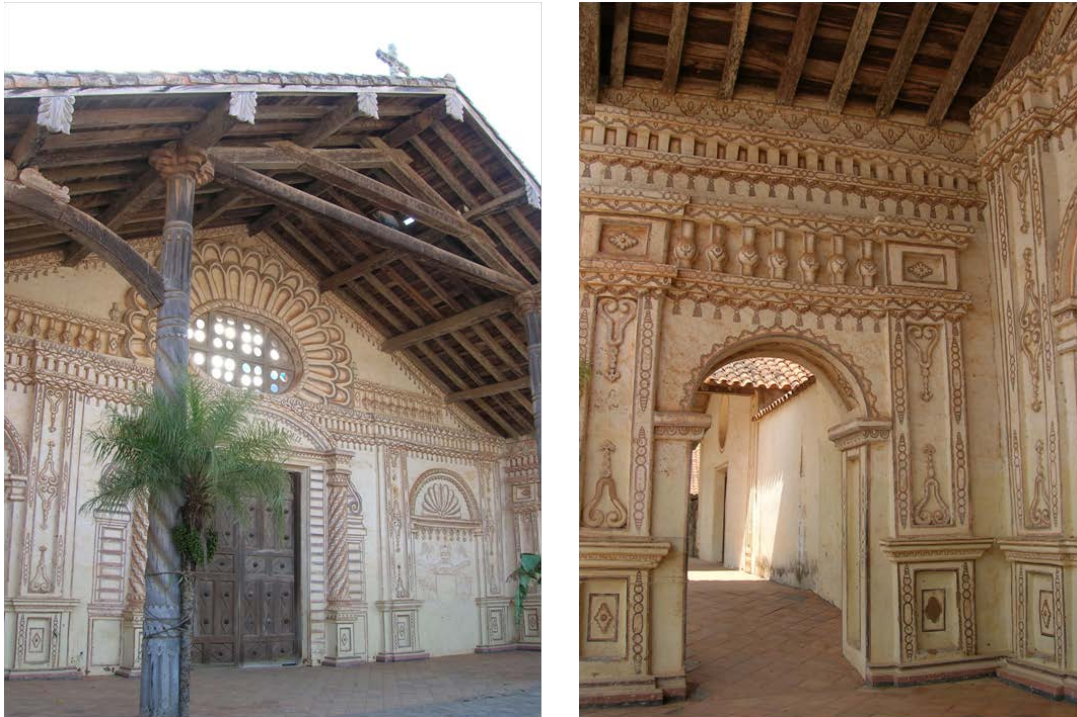
Figura 10. Sin título. Detalle tratamiento fachada, San Xavier. Chiquitos, Santa Cruz de la Sierra. Bolivia. Fuente: Arquitecta María Inés Calderini
