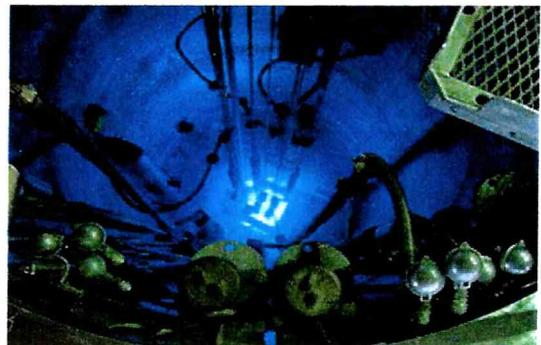
**Figura 3.2:** Izquierda: edificio del Reactor RA6. Derecha, superior: vista externa del tanque del reactor. Derecha, inferior; vista interna del mismo en máxima potencia (luminiscencia azul).
