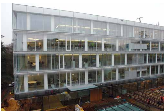
En 2012 finalizaron las obras de construcción del anexo de la sede de la OMC en Ginebra, con lo que por primera vez todos los funcionarios están reunidos bajo un mismo techo.
