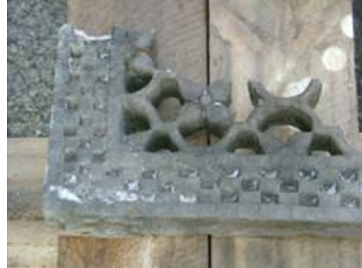
Fotografía 14: Rejilla de roca calcárea luego del crioarenado a 3.5 bar. La limpieza no resulta satisfactoria.
